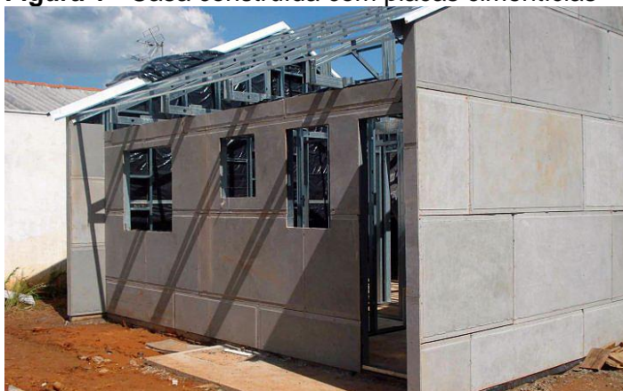
Figura 1 - Casa construída com placas cimentícias
