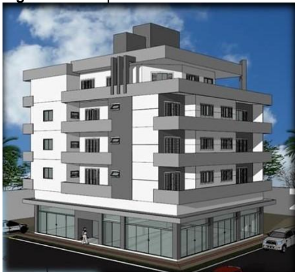
Figura 1 – Perspectiva da obra em estudo
