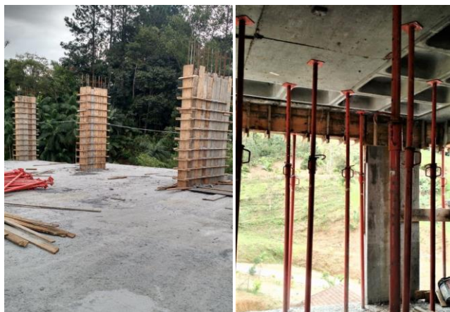
Figura 2 - Processo de construção concreto armado convencional.
