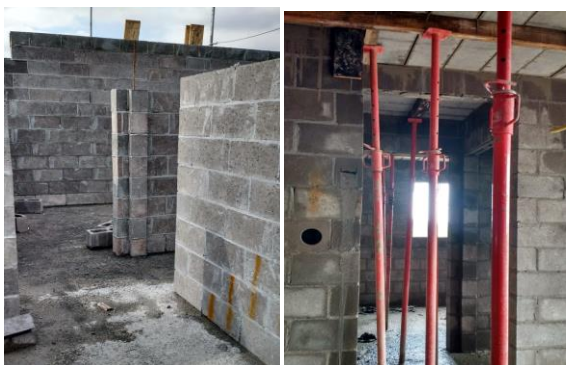
Figura 3 – Imagem processo de construção em alvenaria estrutural.
