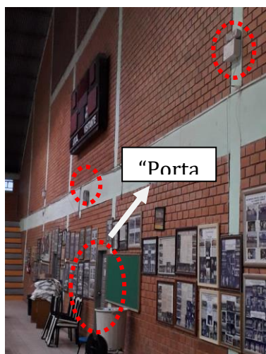
Figura 08 – Luminárias de emergência.
