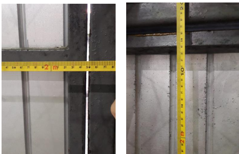
Figura 7 – (a) Largura da saída de emergência 2 e (b) Altura da saída de emergência 2.
