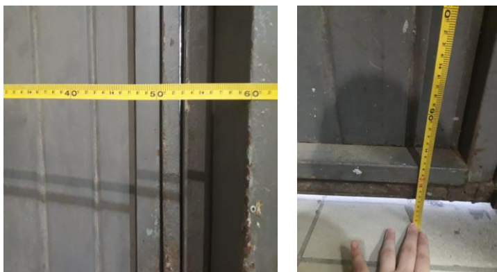
Figura 6 – (a) Largura da saída de emergência 1 e (b) Altura da saída de emergência 1.
