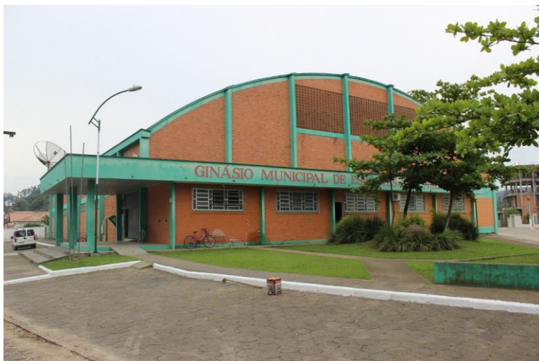
Figura 1 – Fachada Frontal do Ginásio de Esportes.
