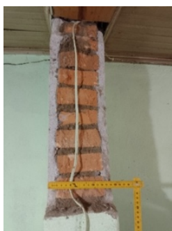
Figura 4 – Estrutura de alvenaria
