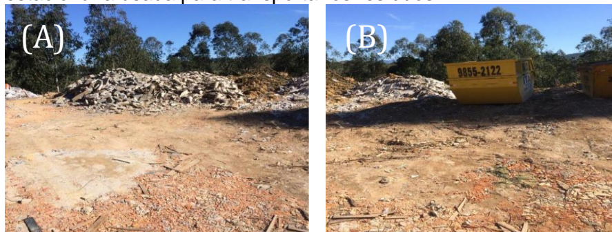
Figura 03 – (a) resíduos classe A depositados diretamente no solo; (b) caçamba estacionária usada para transportar os resíduos
