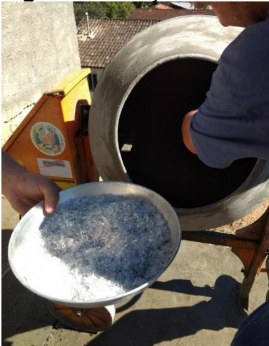
Figura 2 – Adição do PET na betoneira durante a mistura do concreto
