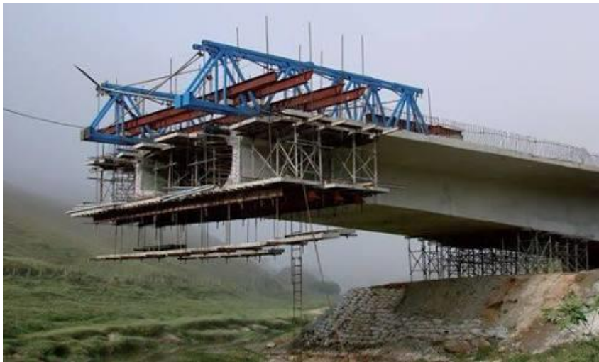
Figura 01 – Ponte por balanço sucessivo
