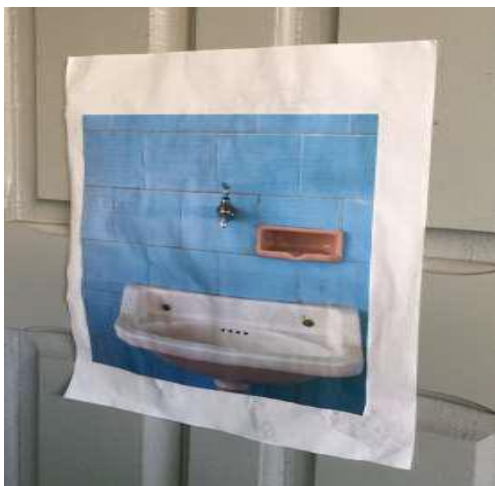
Figura 2 – Papel informativo na porta do banheiro
