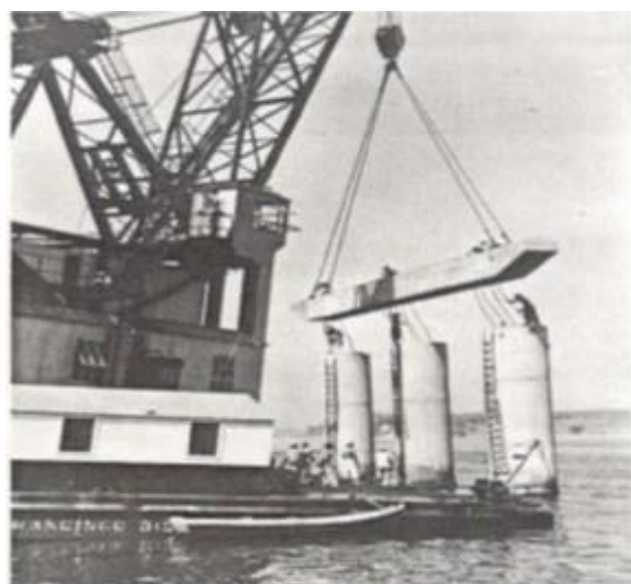
Figura 3 – Colocação de uma viga protendida em seus apoios - RJ
