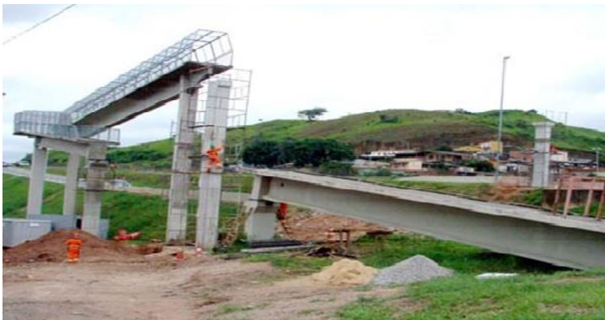
Figura 9 – Reconstrução de passarela com viga pré-moldada, Sorocaba, São Paulo
