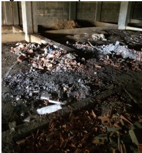
Figura 6 – Reutilização de resíduos classe A no canteiro da obra 3.
