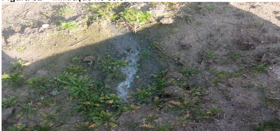
Figura 02 – Infiltração no solo.
