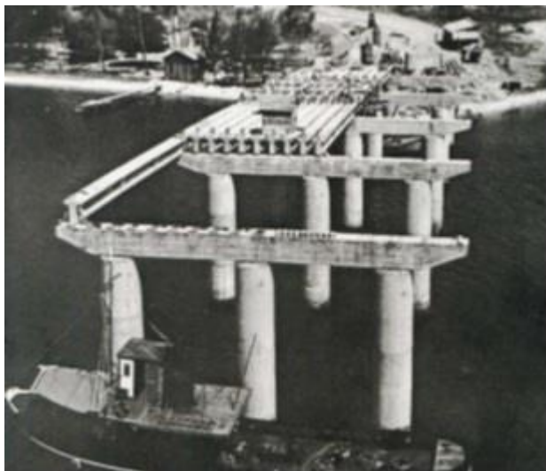
Figura 2 – Vigas de concreto protendido para Ponte do Galeão - RJ
