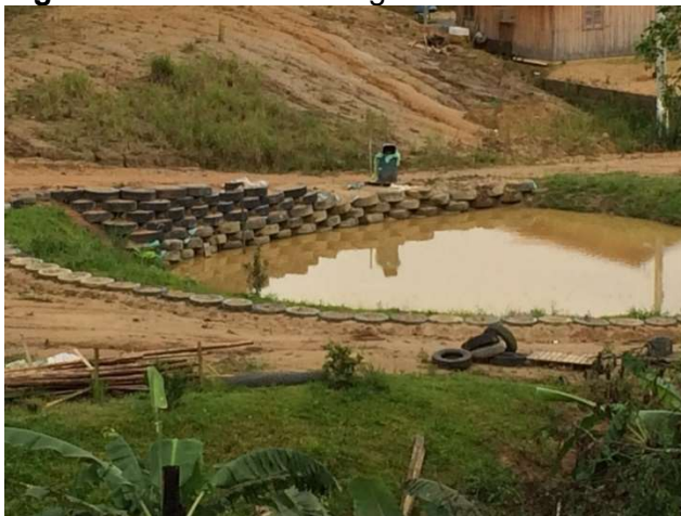
Figura 03 - Acúmulo de água
