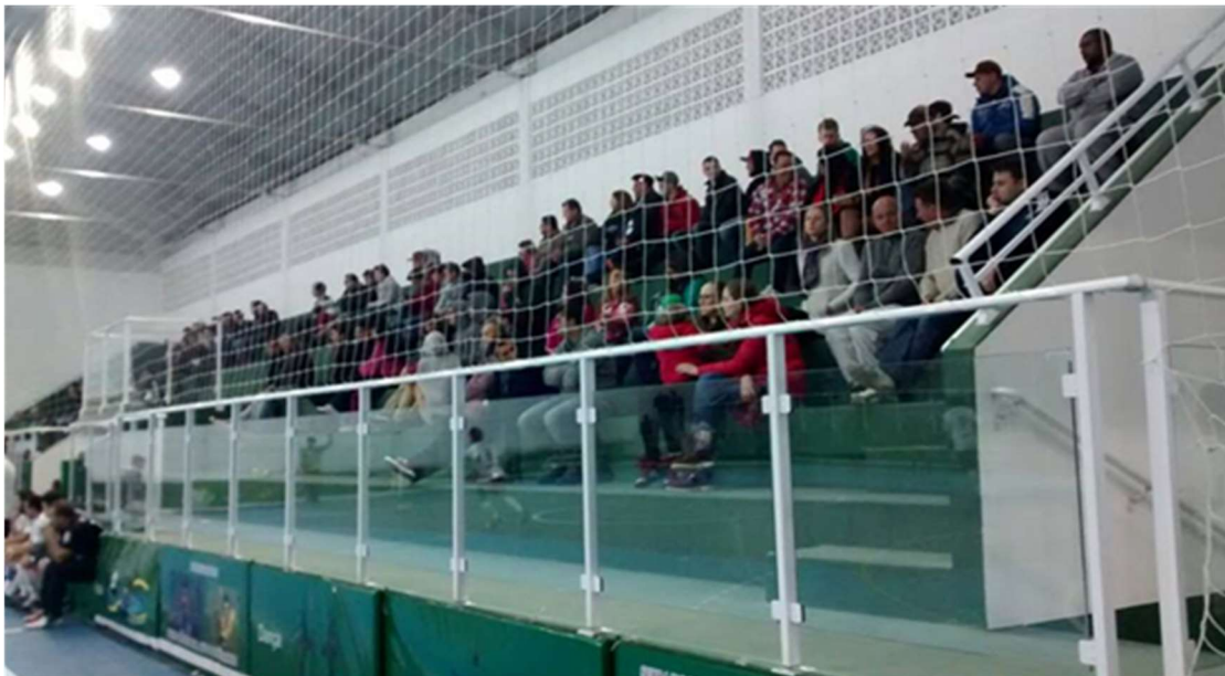
Figura 7 – Arquibancadas e escadas com guarda-corpo e corrimãos
