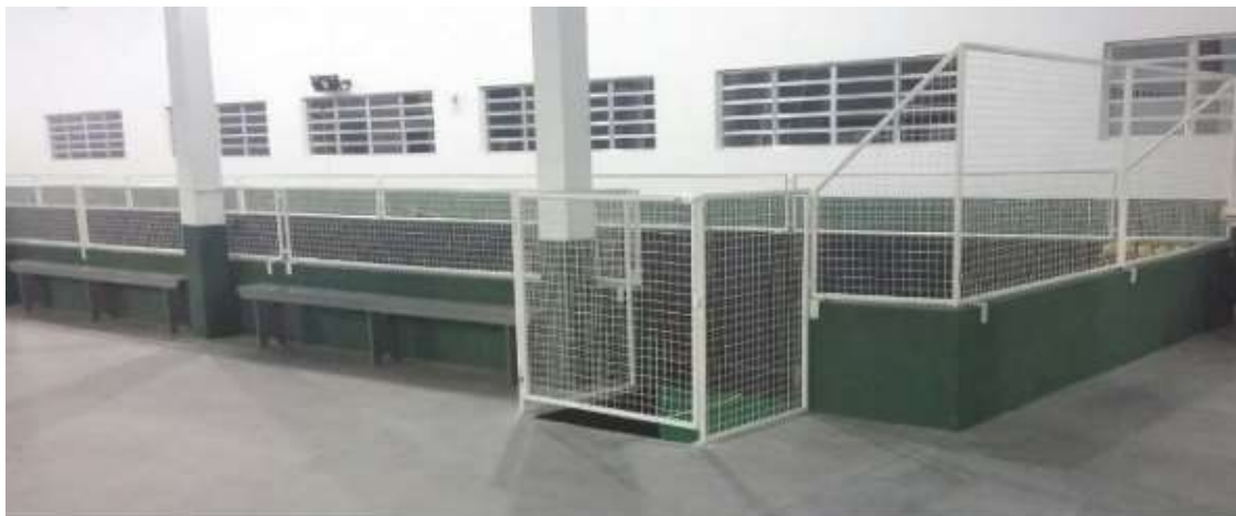
Figura 8 – Guarda-corpo adicionado a cancha de bocha
