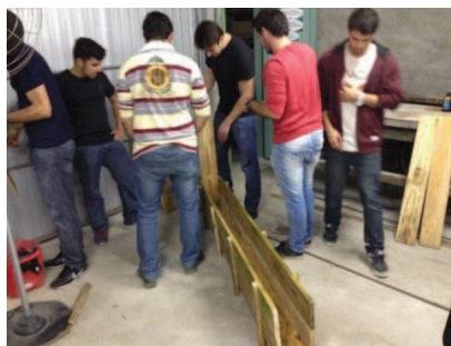
Figura 3- Montagem da caixaria.
