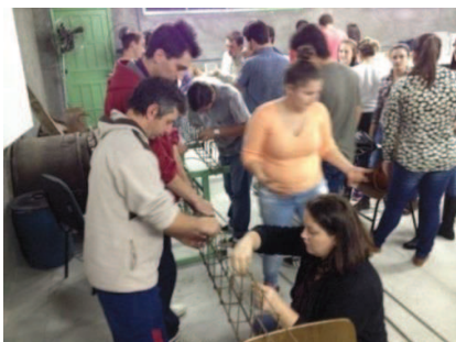
Figura 2- Montagem da armadura.
