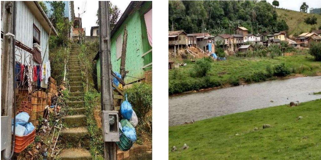
Figura 3 – Urbanização sobre áreas de riscos socioambientais em Orleans – SC
