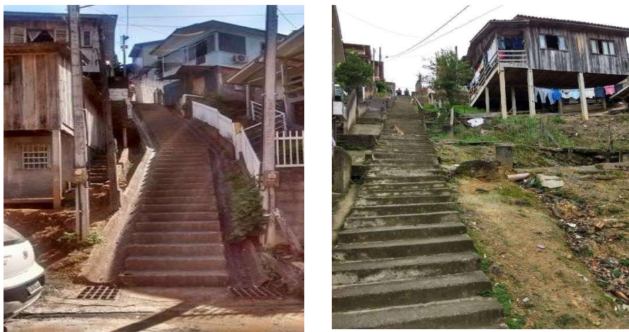
Figura 4 - Urbanização sobre taludes íngremes no bairro Alto Paraná, Orleans – SC
