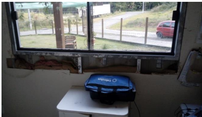
Figura 04 – Perfil galvanizado instalado
