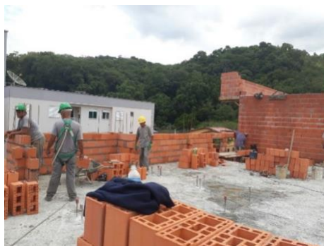
Figura 5 – Funcionários executando o serviço de elevação da alvenaria estrutural.
