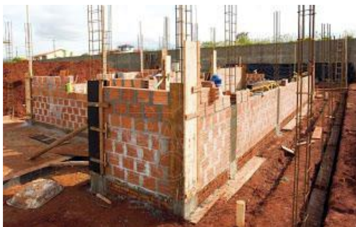
Figura 01 – Construção de alvenaria convencional.
