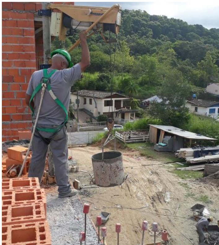
Figura 6 – Transporte da argamassa do térreo até o pavimento de utilização.
