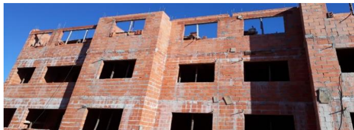
Figura 4 – Fachada lateral da obra em estudo.
