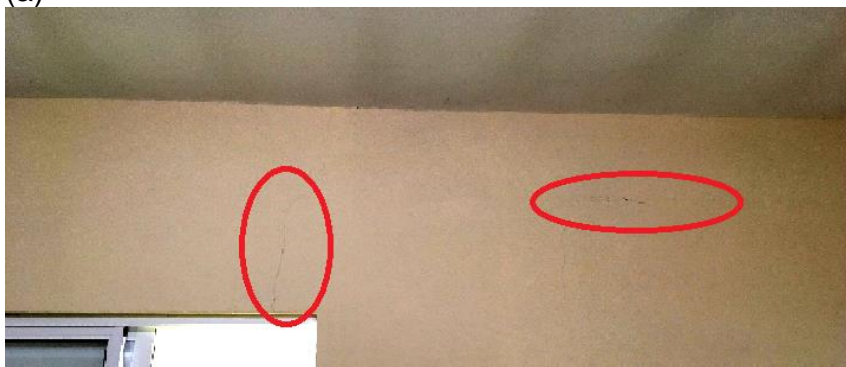
Figura 14 – Fissuras por movimentação térmica.
