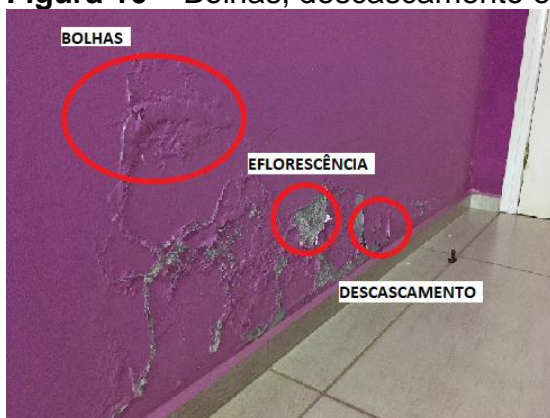
Figura 10 – Bolhas, descascamento e eflorescência.
