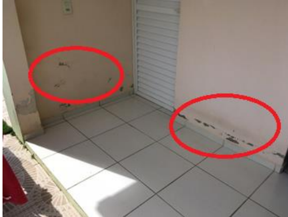
Figura 7 – Bolhas e descascamento.
