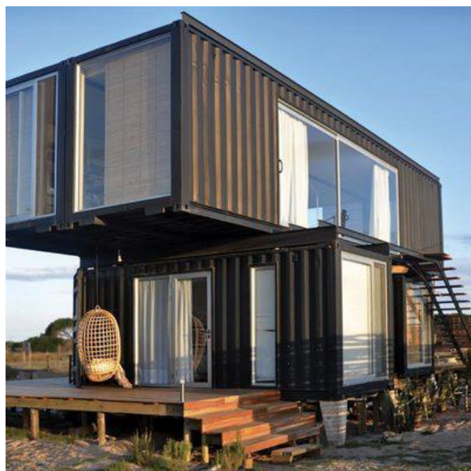
Figura 02 – Construção de container
