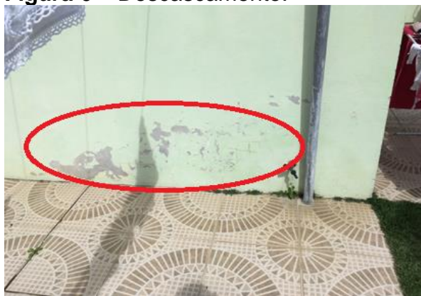
Figura 6 – Descascamento.
