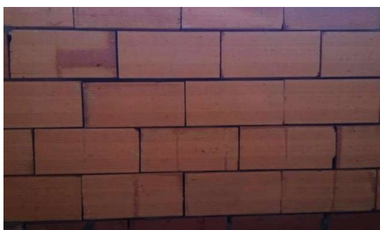
Figura 6 - Parede feita com argamassa industrial.
