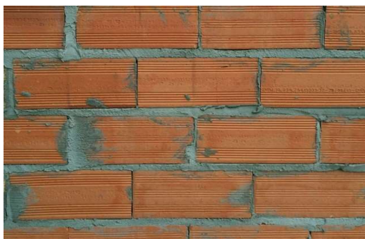
Figura 5 - Parede feita com argamassa tradicional
