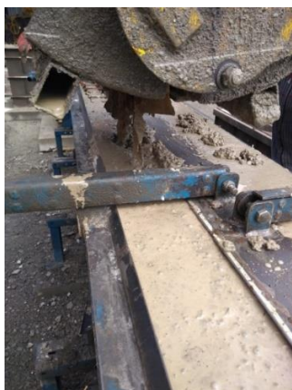
Figura 8 – Concretagem de viga baldrame com concreto auto adensável.
