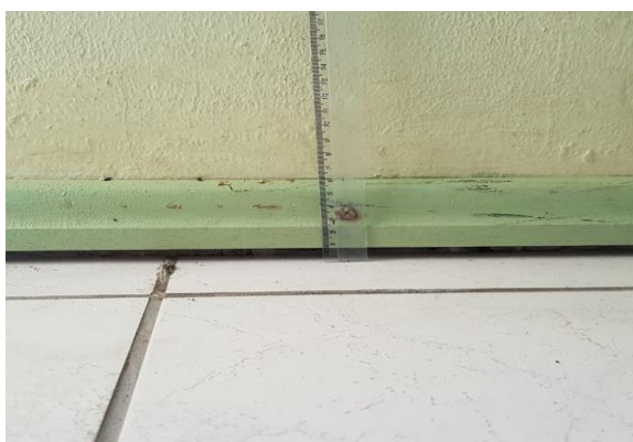
Figura 13 – Rebaixamento do piso e calçada.
