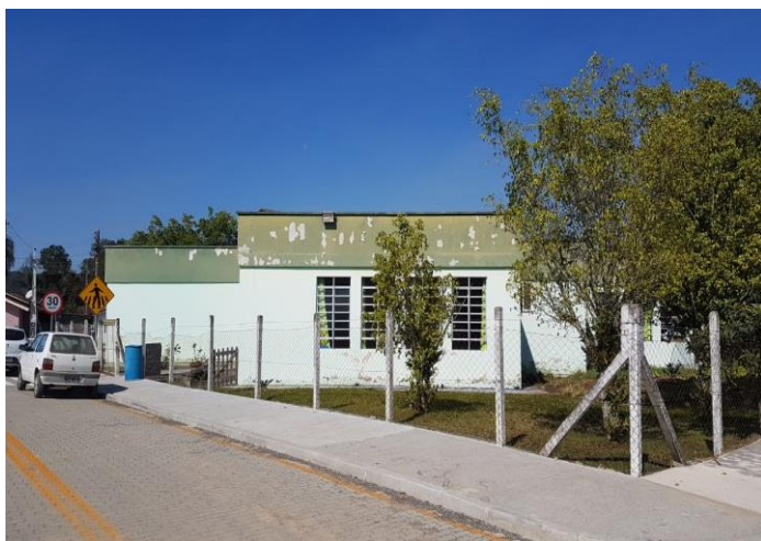
Figura 10 – Vista Frontal da edificação em estudo.
