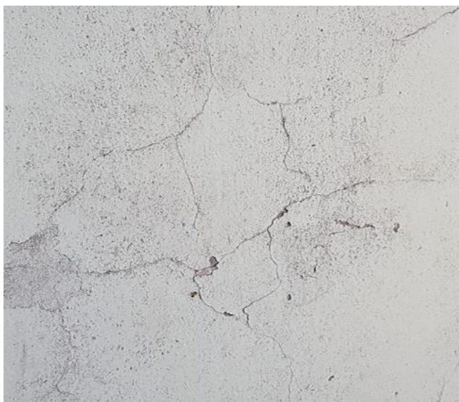
Figura 17 – Fissura Mapeada.
