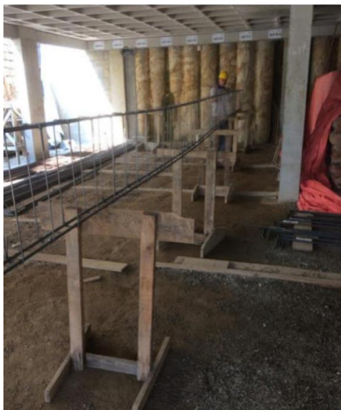
Figura 3 - Processo de confecção de viga.
