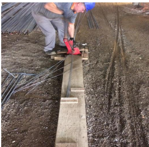
Figura 1 - Processo manual de corte de barras de aço em canteiro de obra.
