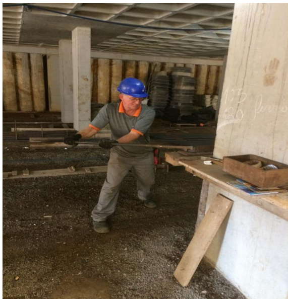
Figura 2 - Processo manual de dobra de barras de aço em canteiro de obra.
