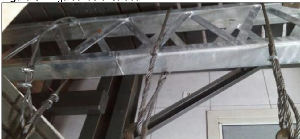
Figura 6 - Viga sendo ensaiada
