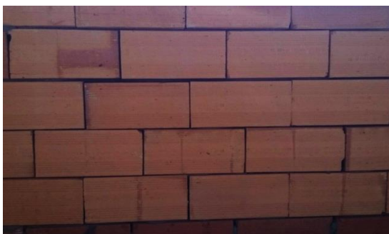
Figura 6 - Parede feita com argamassa industrial.
