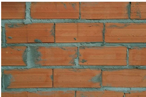
Figura 5 - Parede feita com argamassa tradicional
